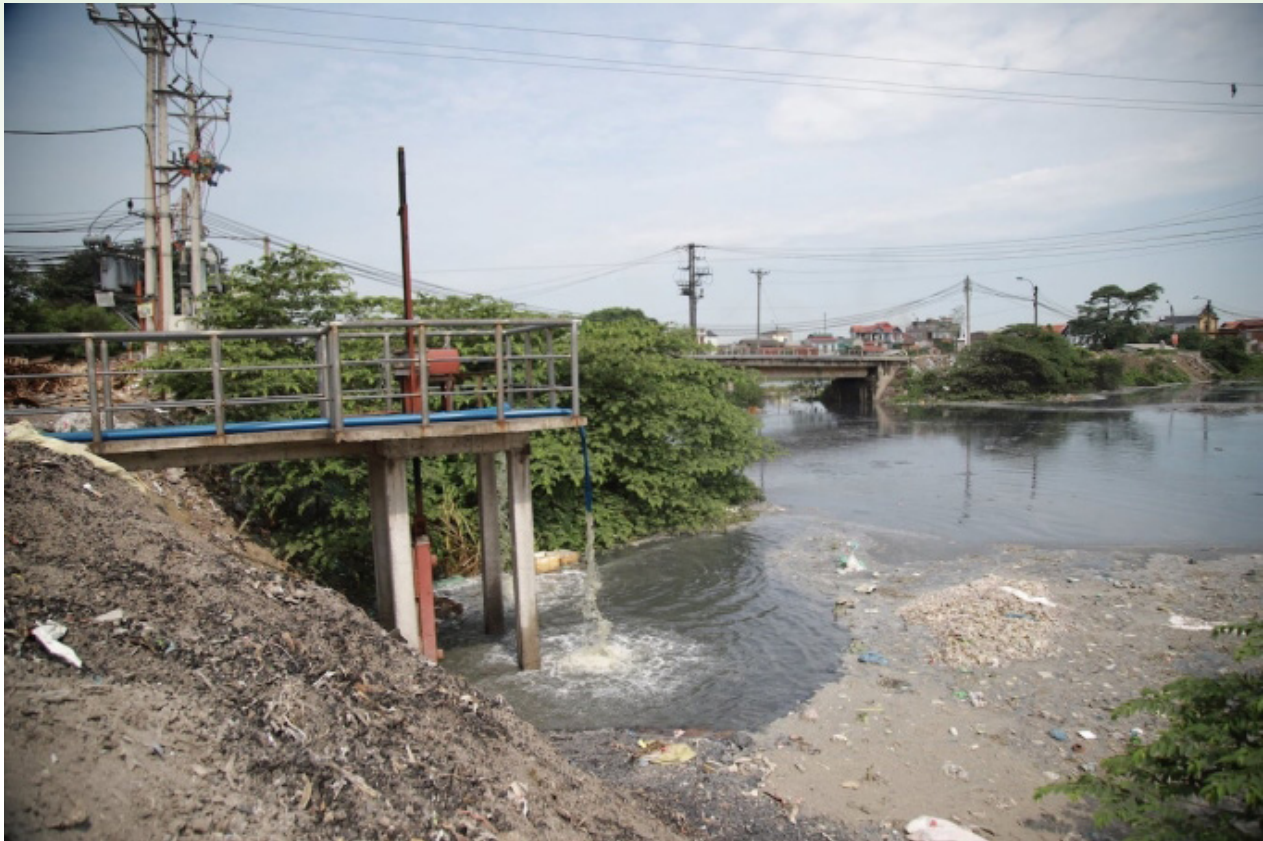
Nước thải vi phạm vượt quá chỉ số môi trường xả ra sông Ngũ Huyện Khê (Bắc Ninh)
